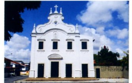
Une porte latérale donne accès aux dépendances de l'église « das Fronteiras », des Fronteiras, repeinte après le décès de Dom Helder.
